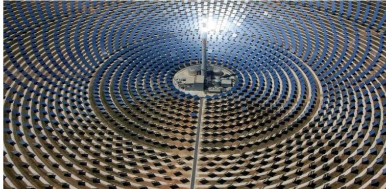
*Figura 11 - Usina Heliotérmica Gemasolar, com torre solar e espelhos planos, Espanha*
